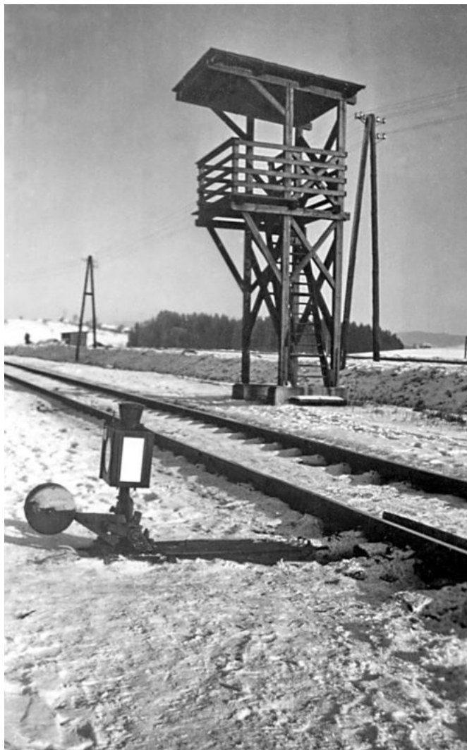
Einer der beiden Kontrolltürme in Summerau
